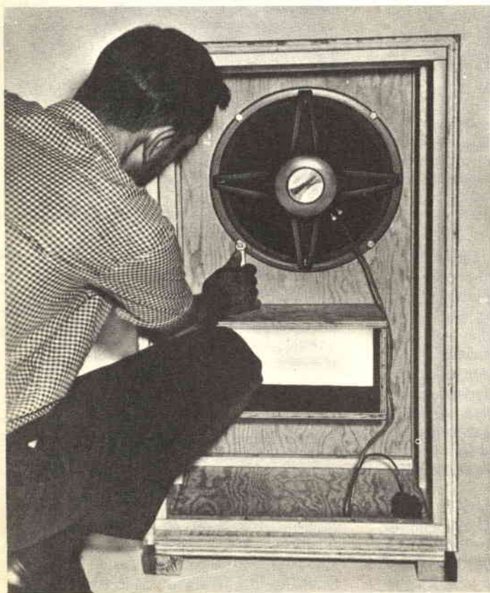
Montando l'altoparlante, non si stringano troppo i dadi di fissaggio. Dietro la porta si noti il condotto che permette l'uso di una porta più grande.
